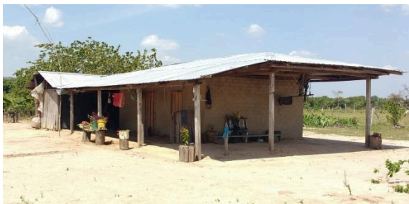
Fotografía 1. Vivienda en techo de zinc y pared de adobe
