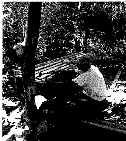
Foto 9 Construcción de cama
