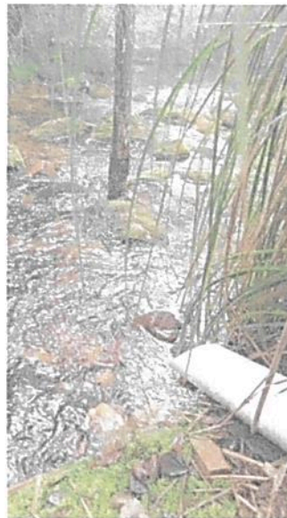
Foto 3. Estructura de descarga
