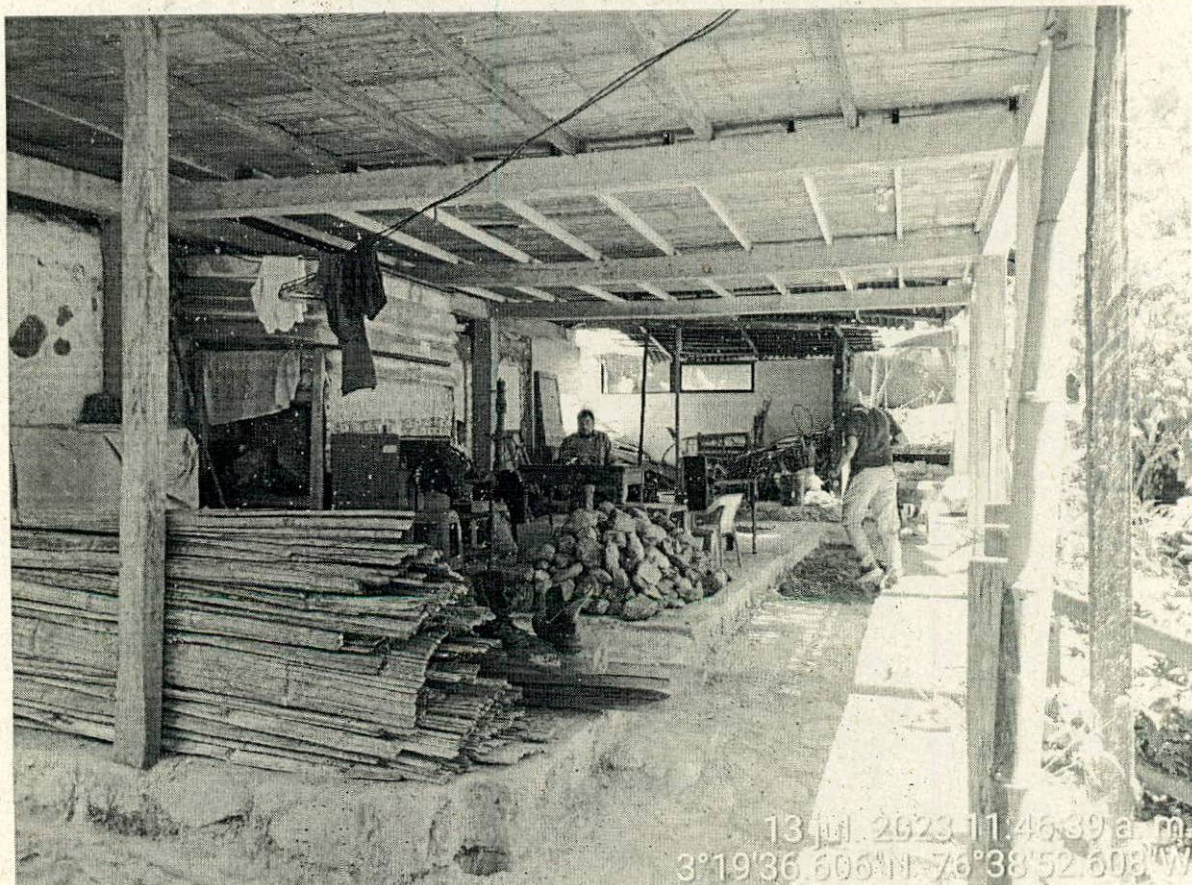
Foto 4: Infraestructura intervenida, visita fecha 13 de julio de 2023
