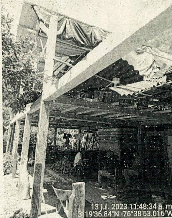
Foto 3: Infraestructura intervenida, visita fecha 13 de julio de 2023
