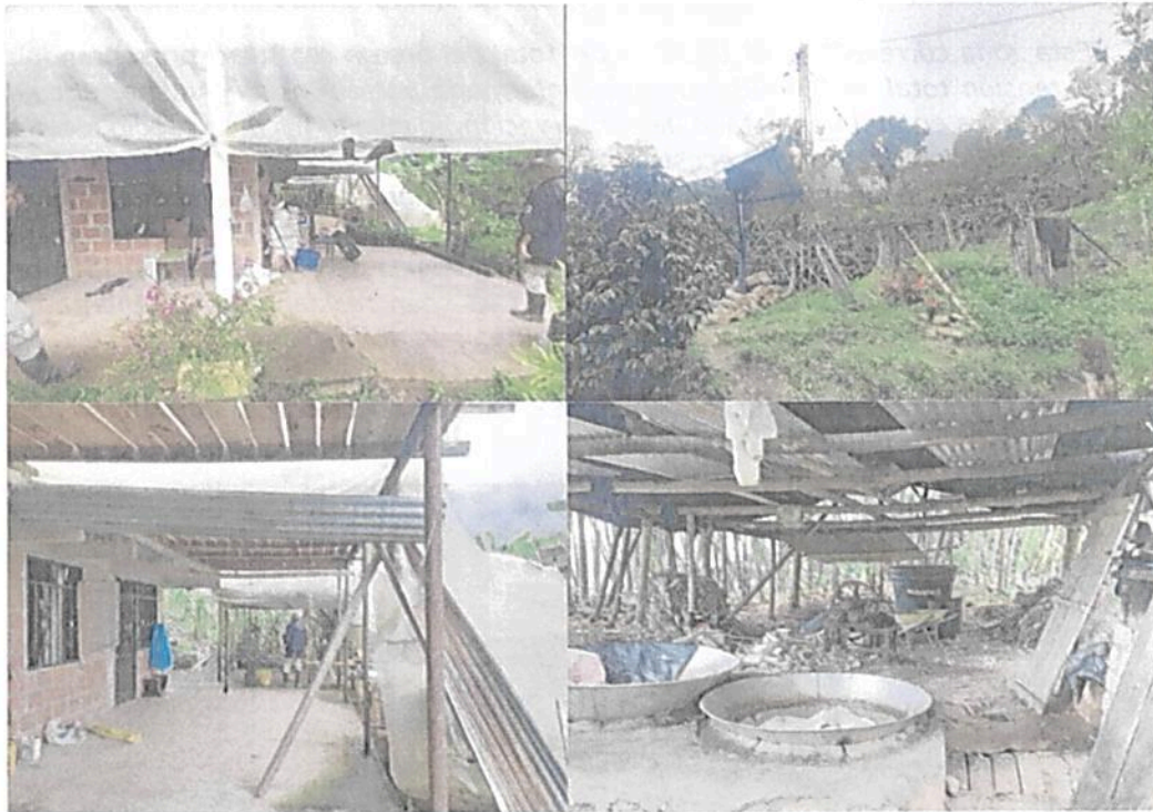
Figura 6. Zona de Uso Intensivo e Infraestructura presente en la RNSC "MIRANDA" Fuente: visita técnica PNNC 13 al 17 de marzo de 2023.
