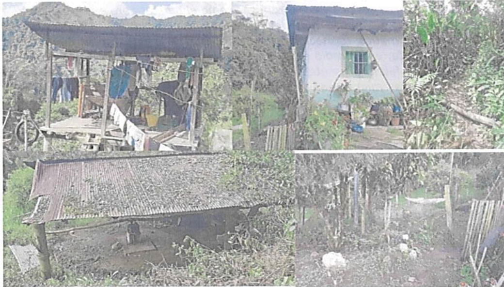
Figura 6. Zona de Uso Intensivo e Infraestructura presente en la RNSC "LA ARGENTINA" Fuente: visita técnica PNNC 13 al 17 de marzo de 2023.
