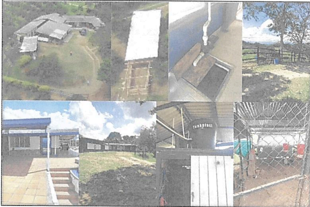
Imagen 8. Zona de Uso Intensivo e Infraestructura de la RNSC 076-22 VILLA LAURA. Fuente: Informe técnico CVC.
