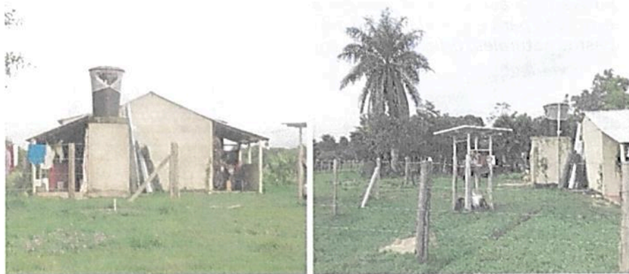
Figura 7. Zona de uso intensivo e infraestructura presente en la RNSC Luna Nueva 1.
