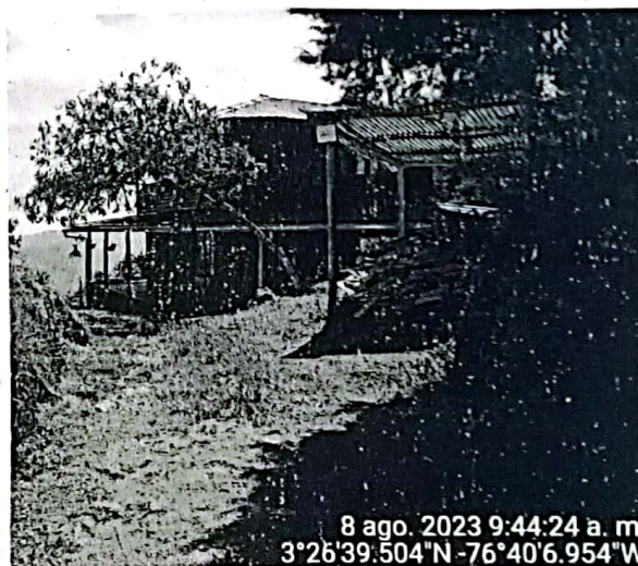
Foto 3. Vista de infraestructura de dos plantas construida en madera y zona almacenamiento de madera.
