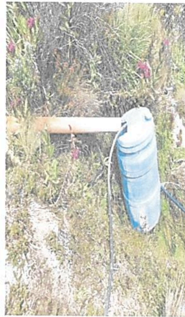
Ilustración 3. Caja desarenador.
